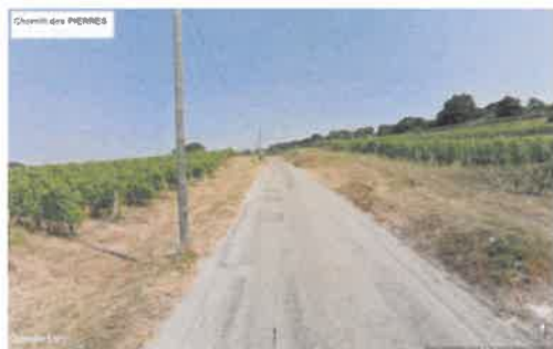
Chemin des PIERRES 1er tronçon
